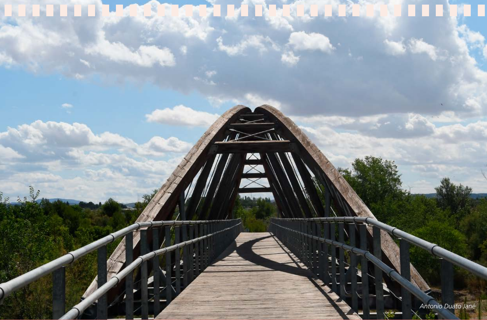
Pasarela de los Estrechos sobre el río Gállego. San Juan de Mozarrifar-Montañana
