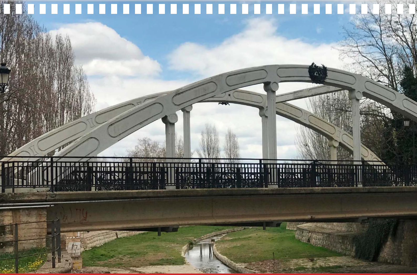
Puente de San Miguel sobre el río Isuela en Huesca
