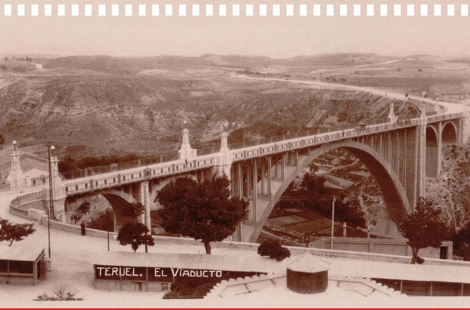
Viaducto de Teruel
