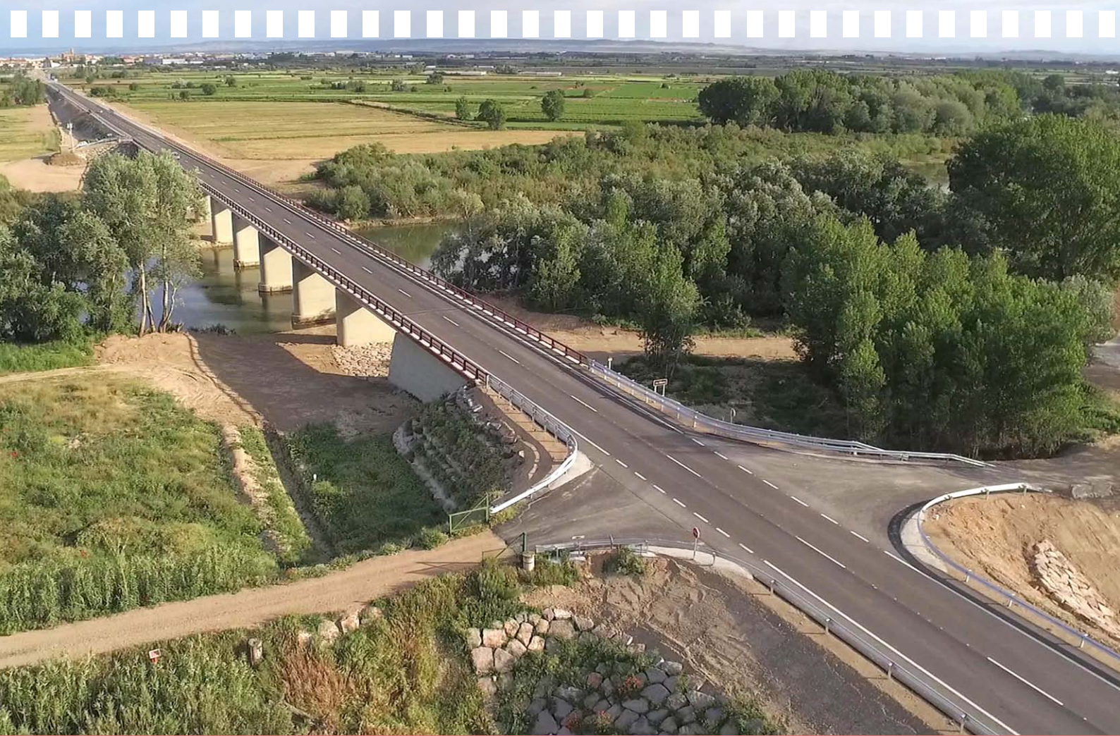
Puente de Alagón sobre el río Ebro
