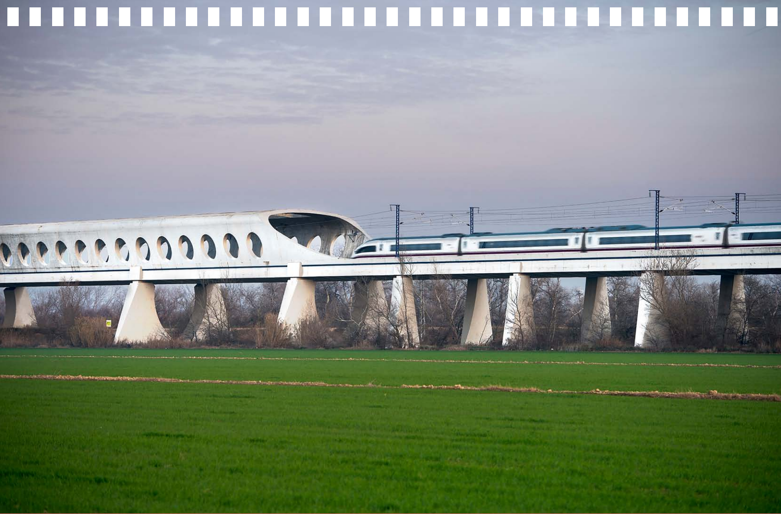
Puente de Osera de Ebro sobre el río Ebro
