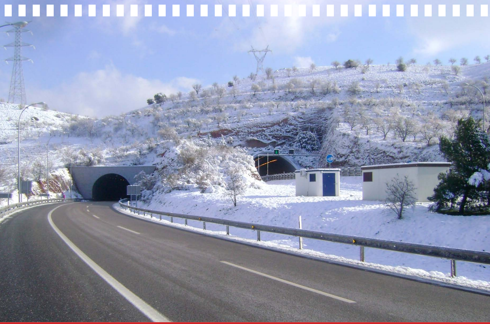
Túneles de Morata en la Autovía A-2
