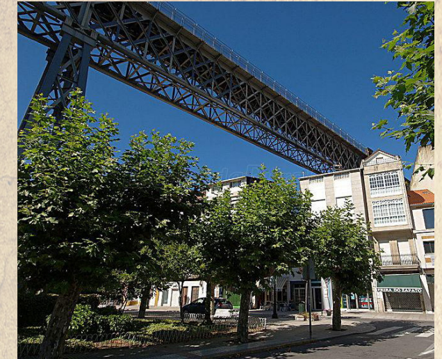
Viaducto de Redondela de celosía metálica
