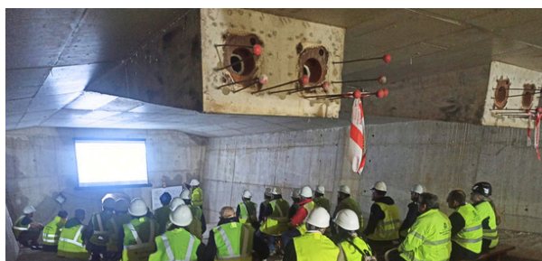
Los profesionales, dentro de uno de los brazos del viaducto.
